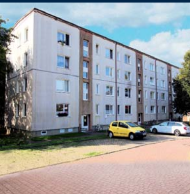
Mehrfamilienhaus 17179 Behren-Lübchin OT Viecheln Schloßstraße 10, 12, 14 Pos. 11
