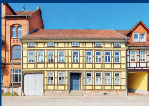
89 Mehrfamilienhaus in Ellrich
