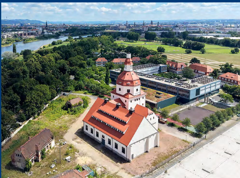
05 Industriedenkmal „Erlweinturm“ in Dresden an der Messe
