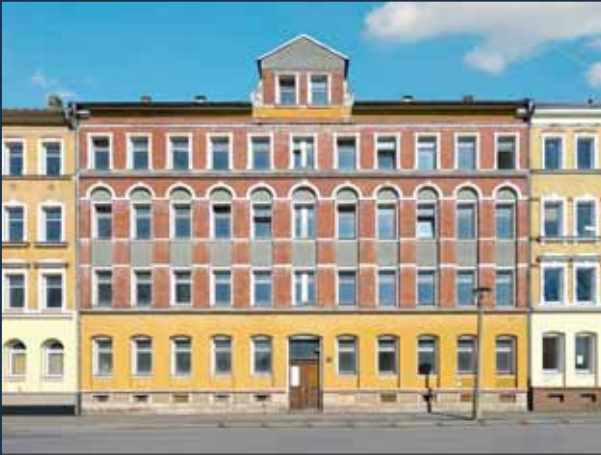
Mehrfamilienhaus in Chemnitz, Pos. 55
