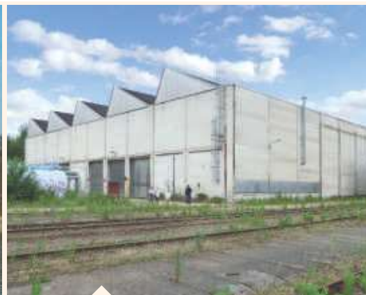
Zwickau Gewerbeobjekt Limit € 65.000,-- Erlös € 404.000,--
